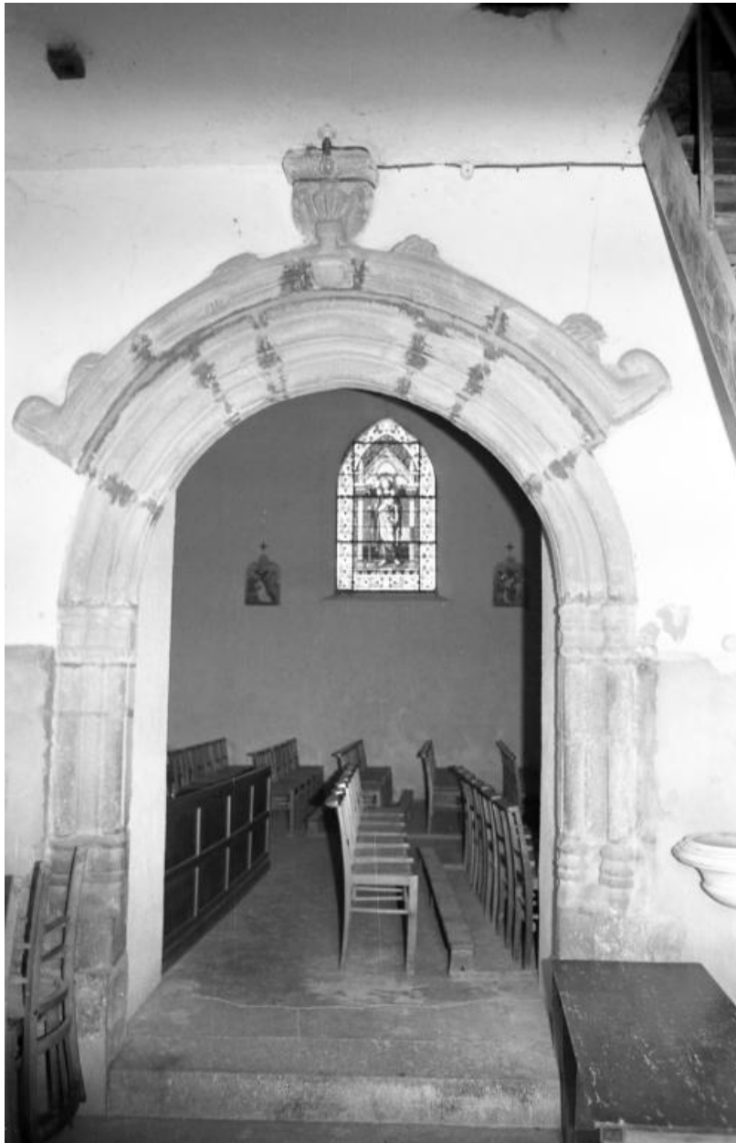
Portes à l'intérieur du porche, état en 1972
