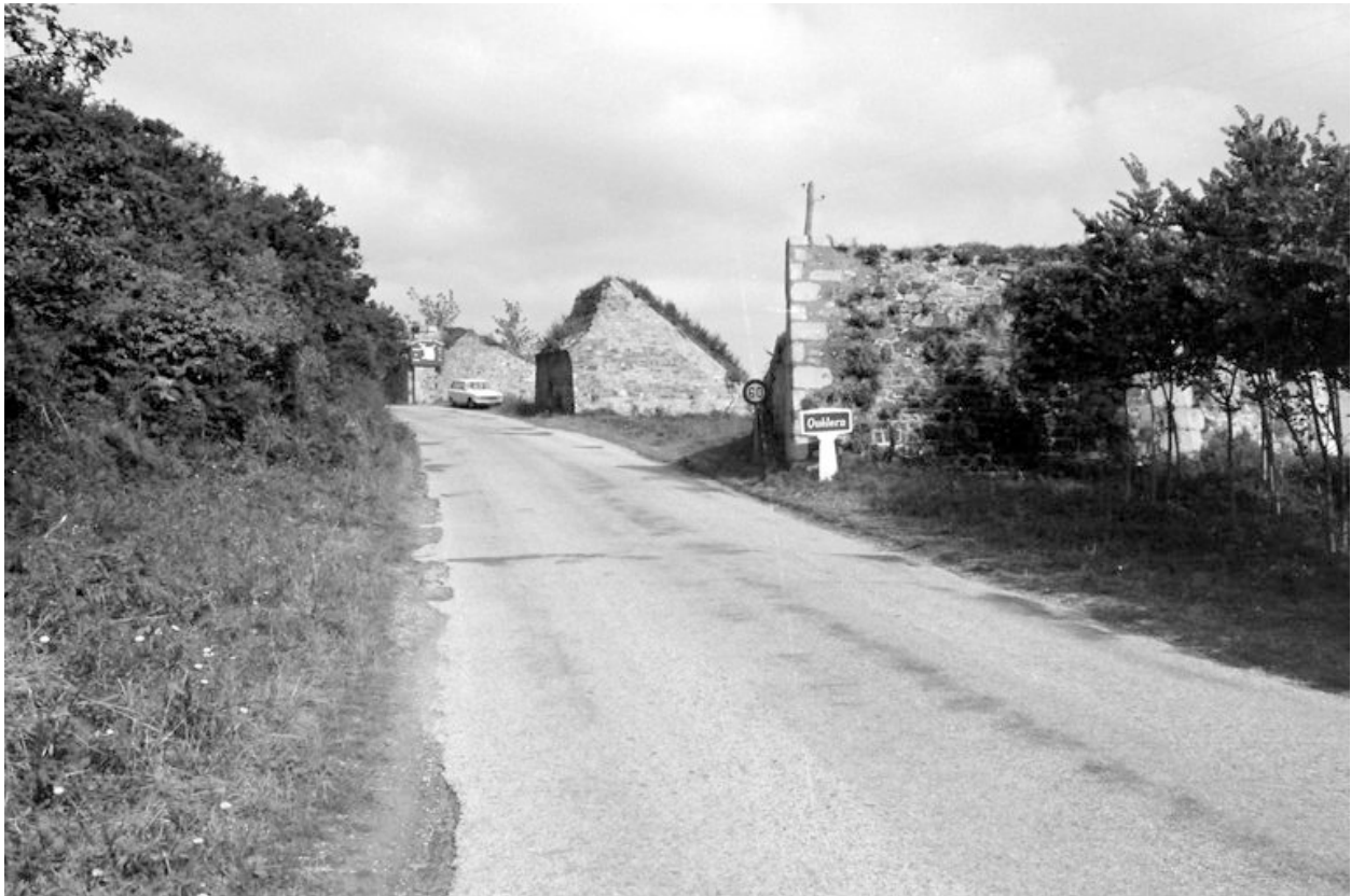
Vue des lignes de Quéléren en 1972 : vestiges de la porte de Crozon
