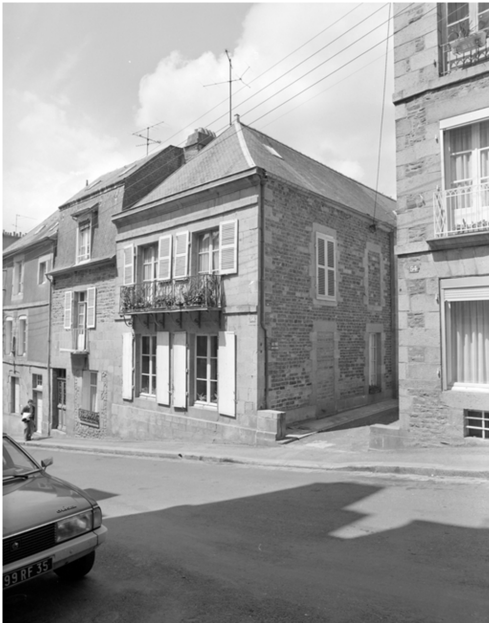
Vue générale de la façade sud.
