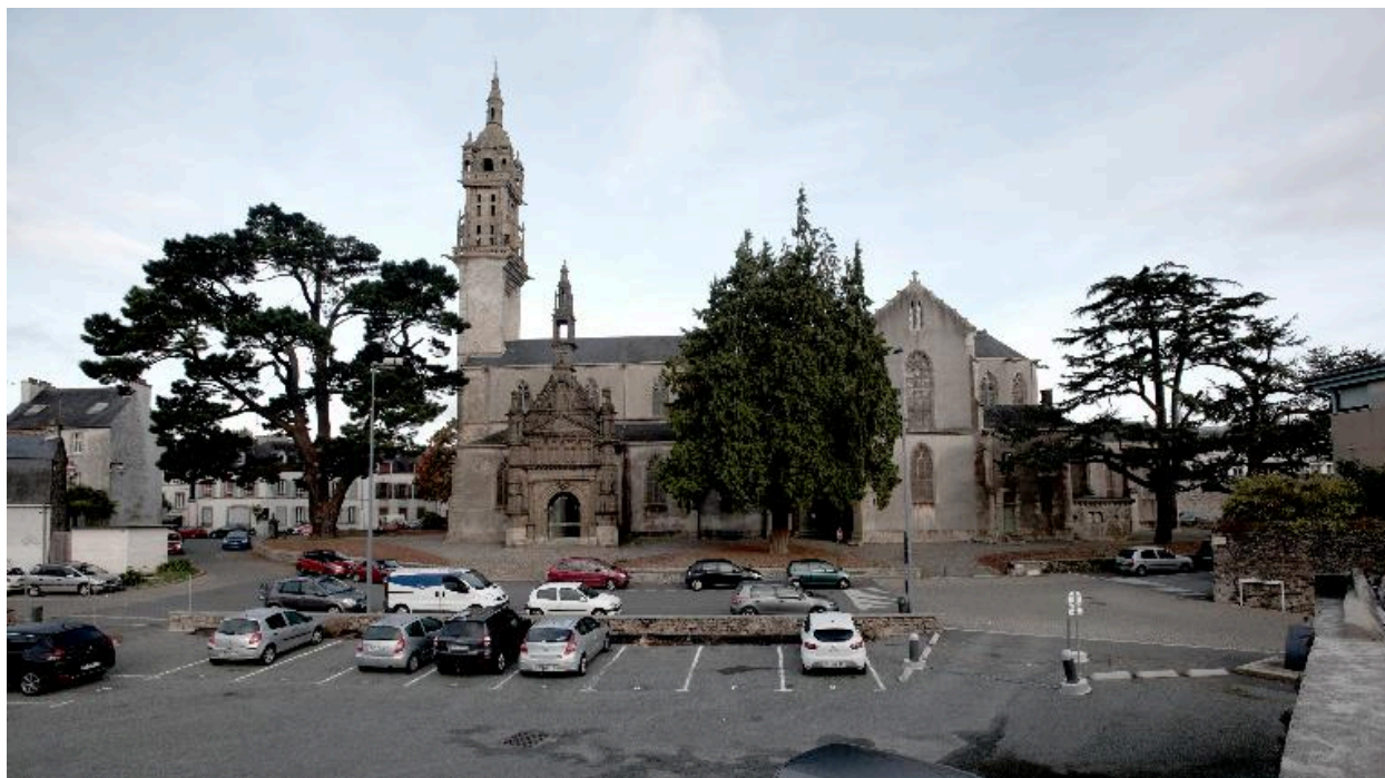
Vue de situation de l'église
