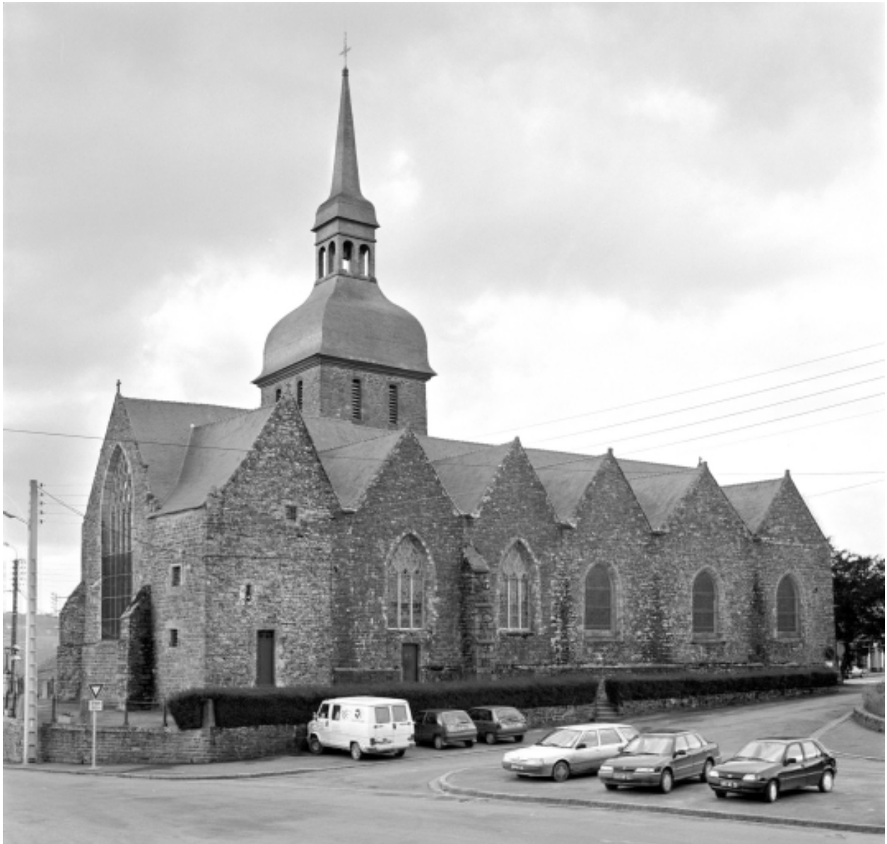
Vue générale nord
