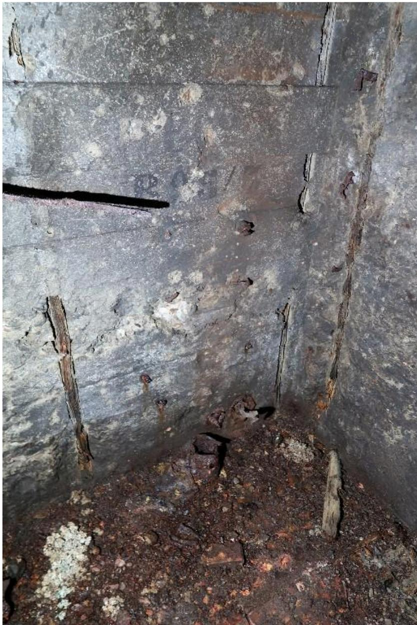
Vue de la salle de garde nord : détail de l'angle nord-est, emplacement du boîtier de connexion téléphonique avec la numérotation B 25 / 7 du bunker. Au sol, la conduite d'arrivée des câbles. Les murs sont constellés d'éclats et noircis par la fumée
