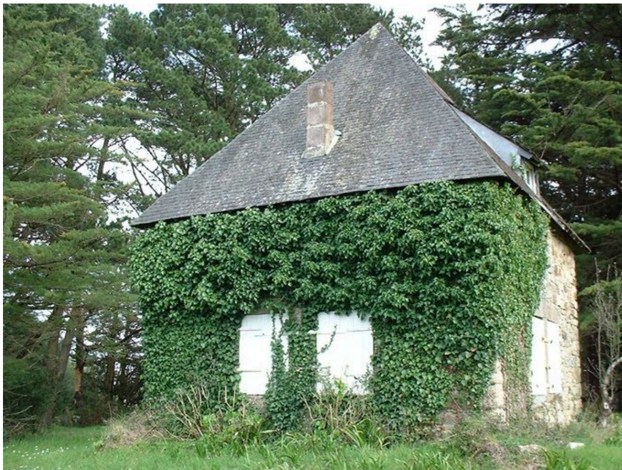
Vue générale de la Guérite des douaniers de Barrarac'h
