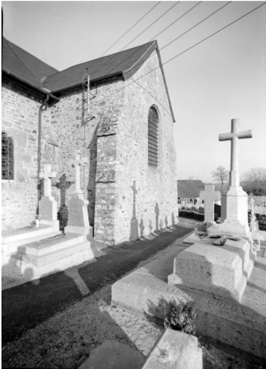
Elévation sud-ouest, sacristie : vue générale
