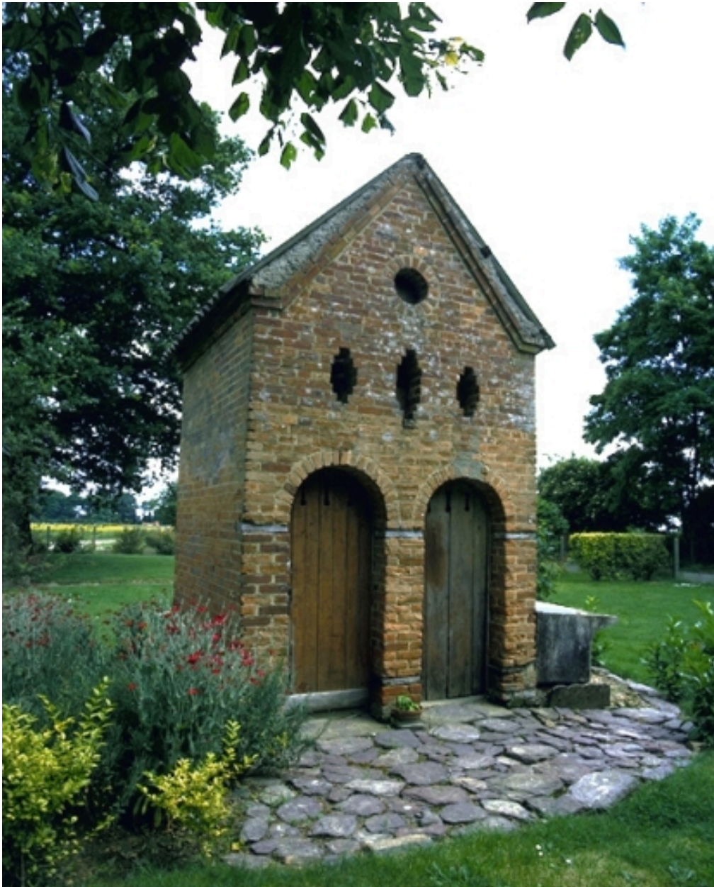
Latrines du château : vue générale est
