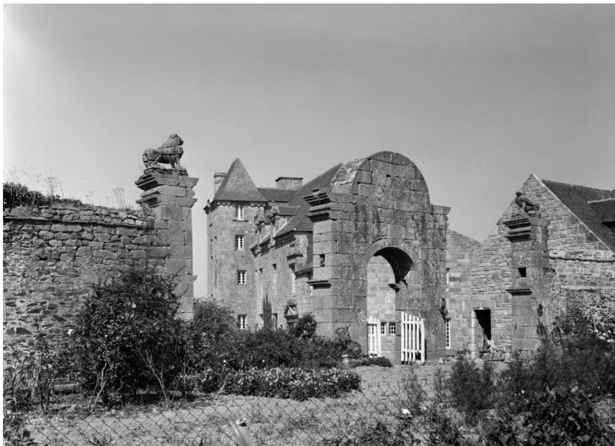
Vue face est du portail est, prise du sud-est
