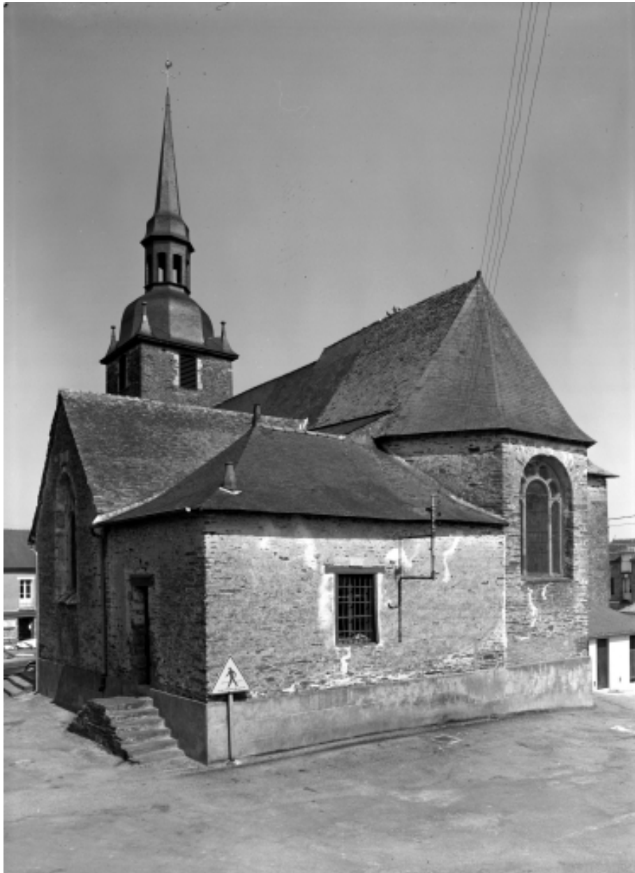
Elévation Est : vue générale
