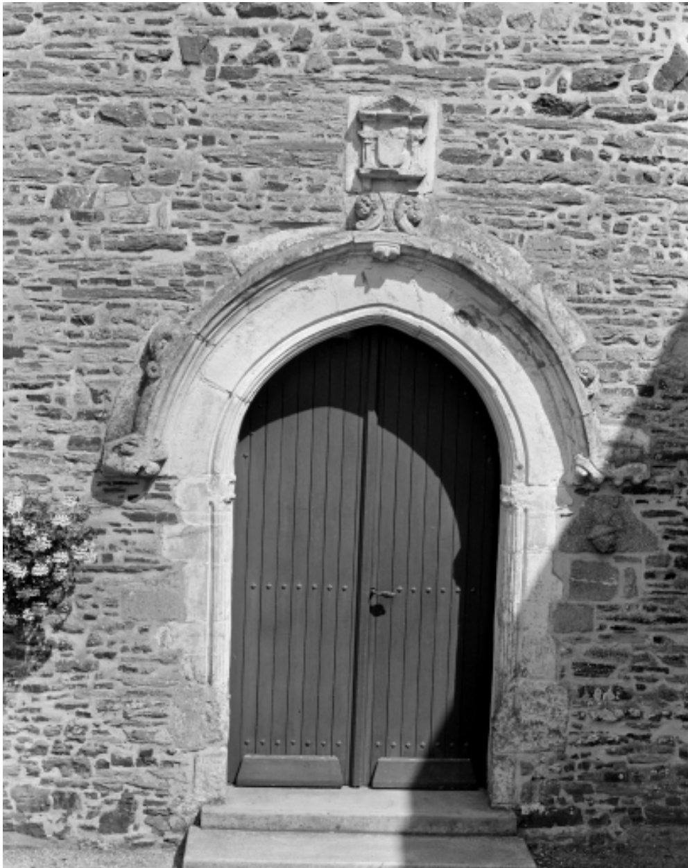
Elévation Nord, bras du transept, porte : vue générale
