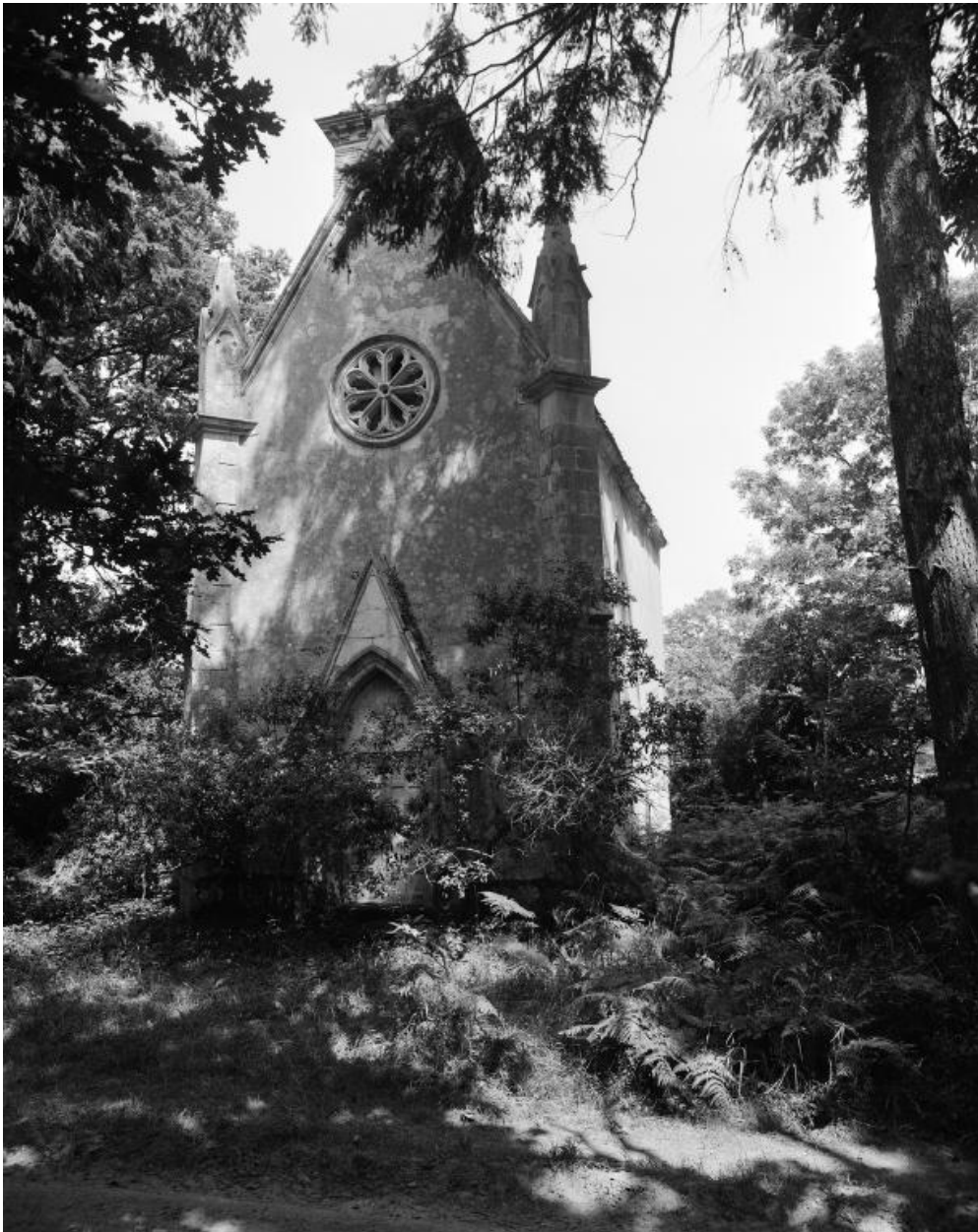
Château, chapelle, vue générale nord.
