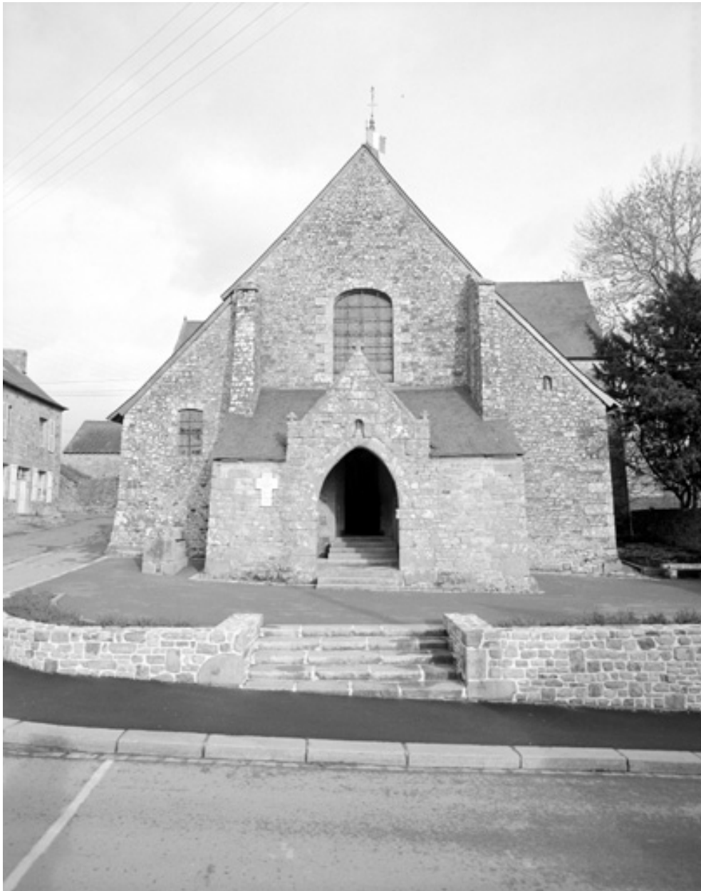
Elévation Ouest : vue générale
