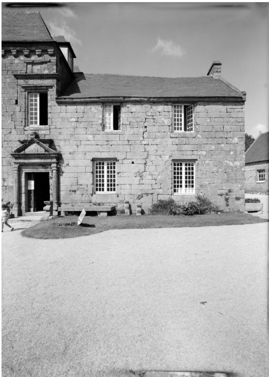
Vue d'ensemble façade sud de la partie est du bâtiment
