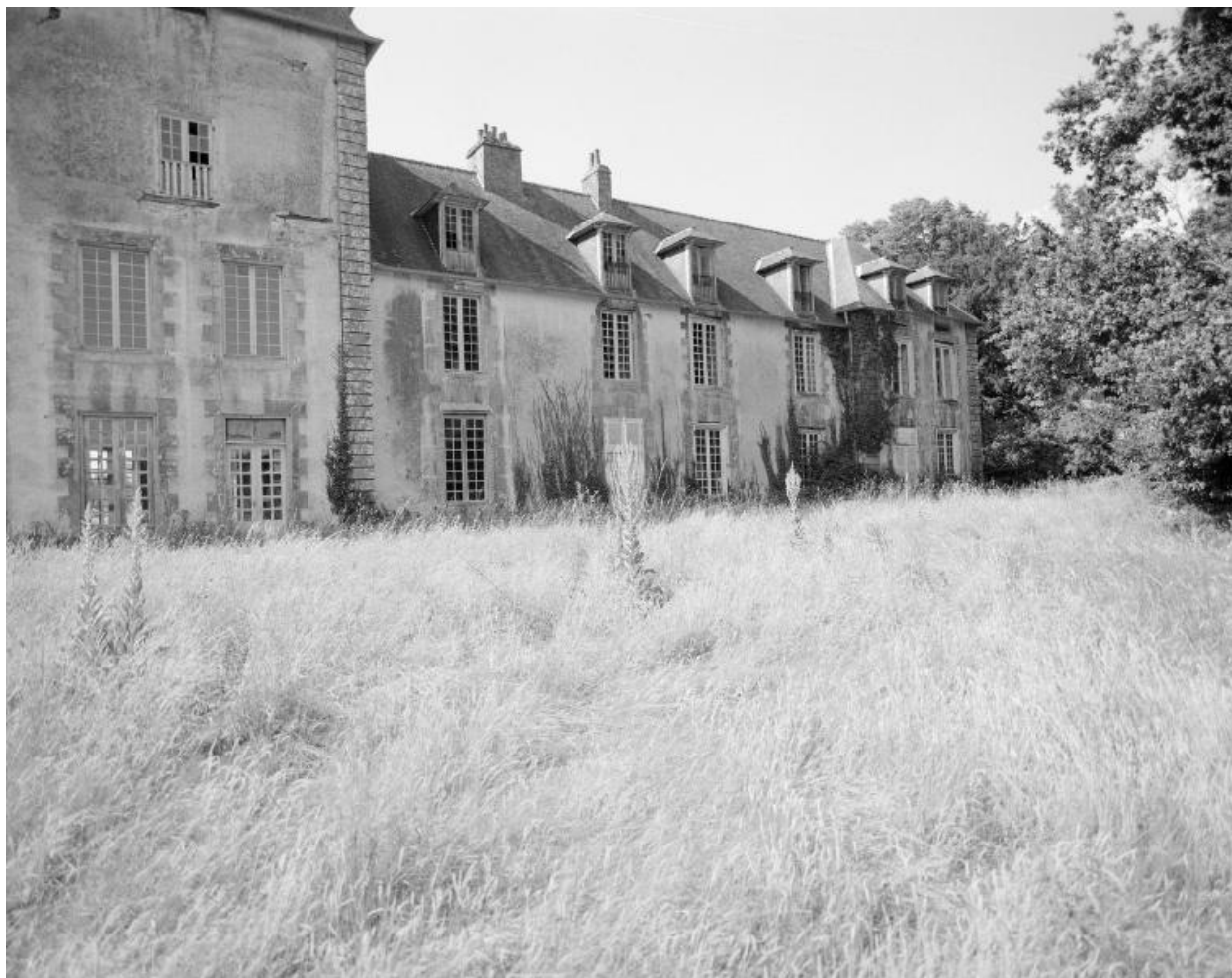
Elévation sud, aile est, vue sud-ouest
