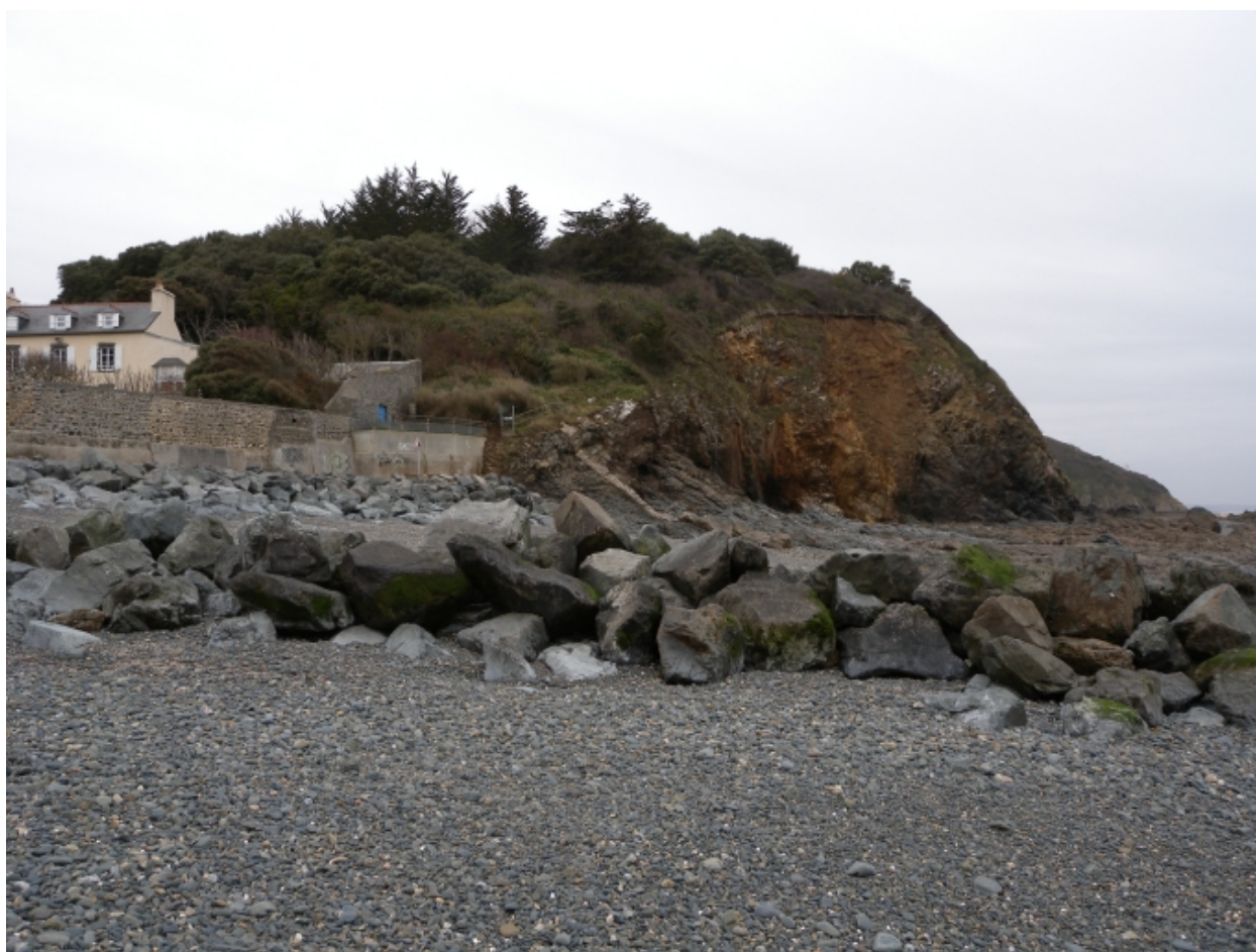
Vue du front de port aménagé avec murs de soutènement, parking, cales et enrochements
