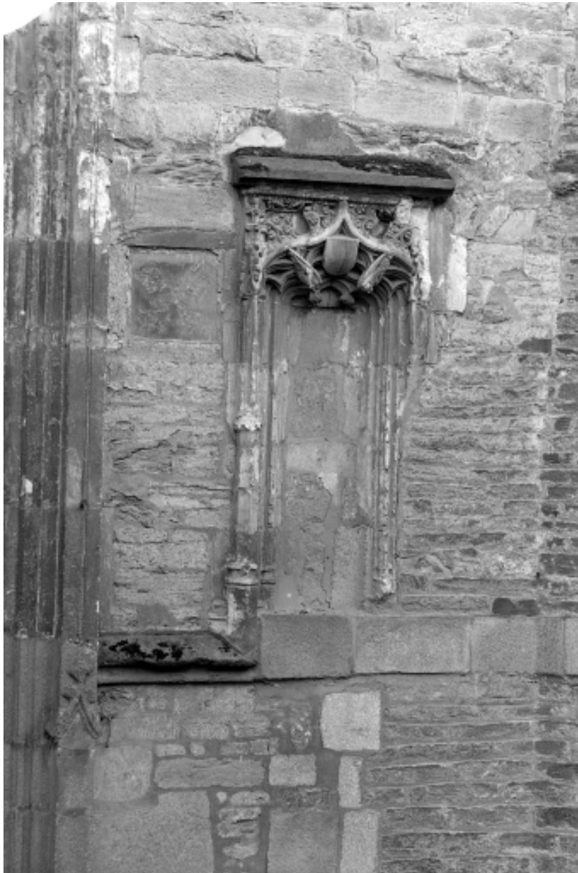
Élévation Ouest, porte, niche à dais droite : vue générale.
