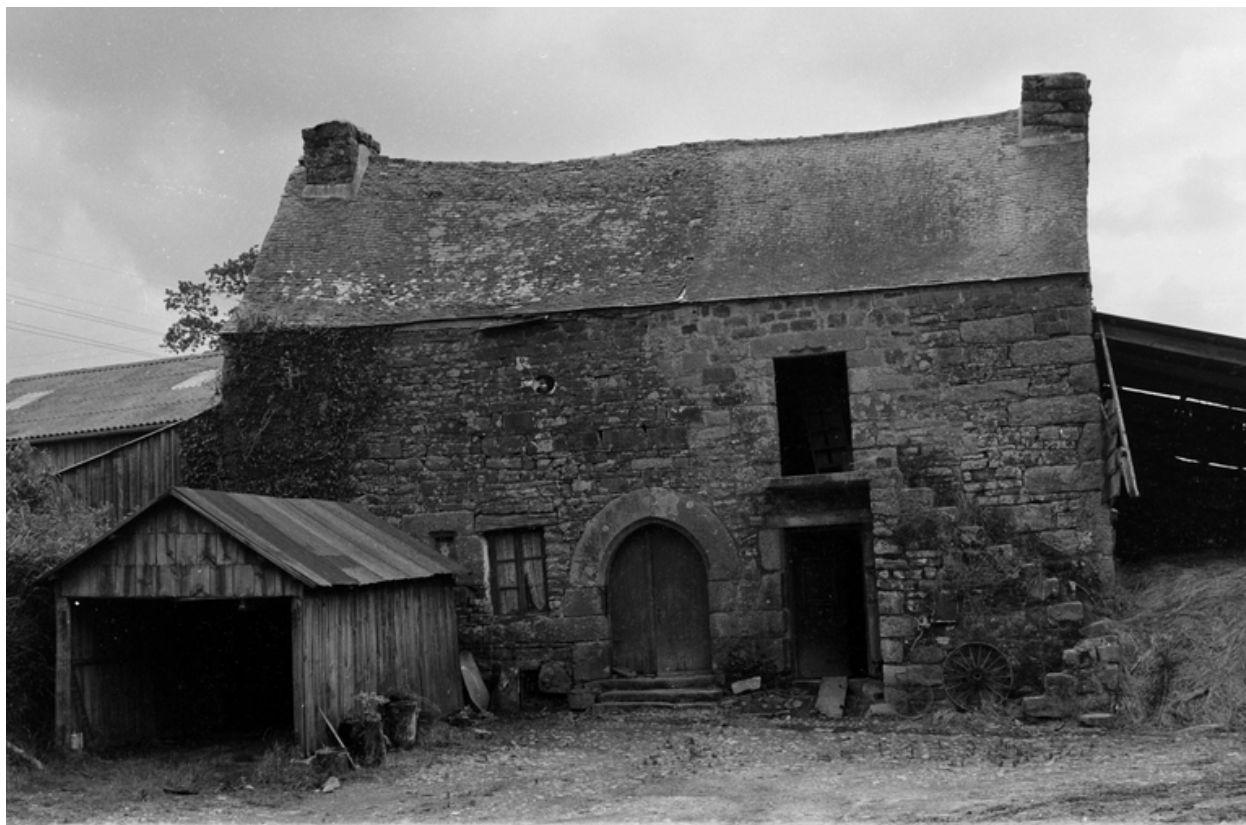
Maison (Kermarck) : vue de la façade nord de la ferme
