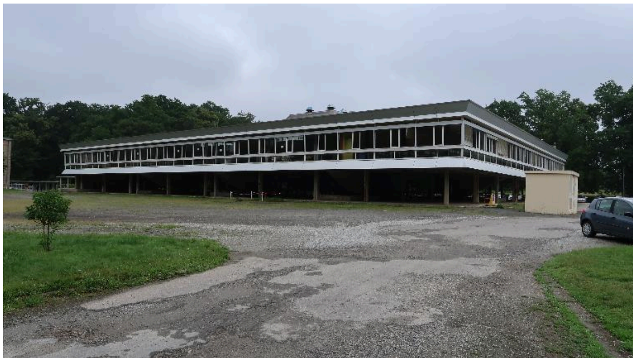
Le service de restauration en 2018, angle sud-ouest.
