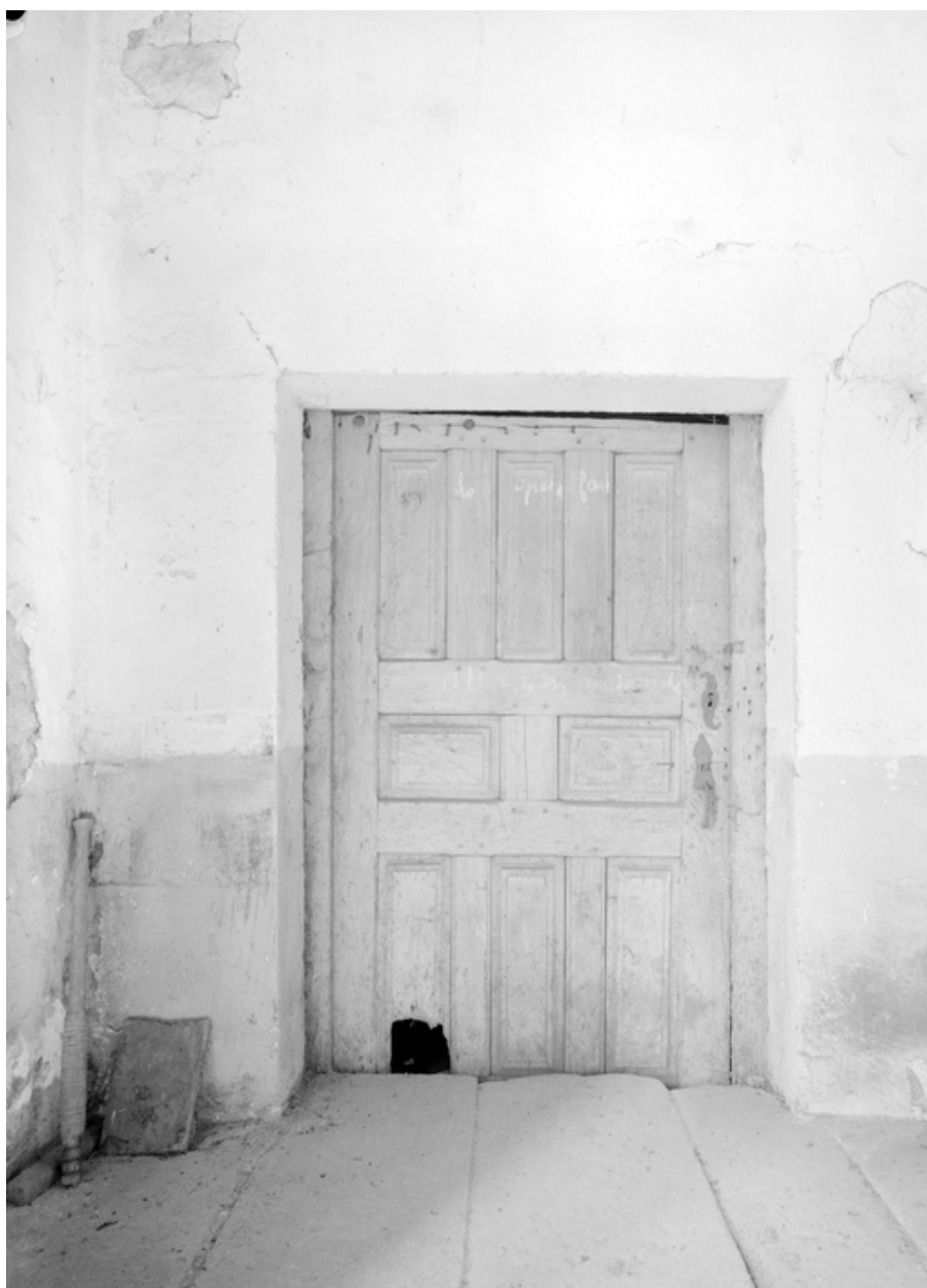
Porte du grenier de l'aile ouest, état en 1967
