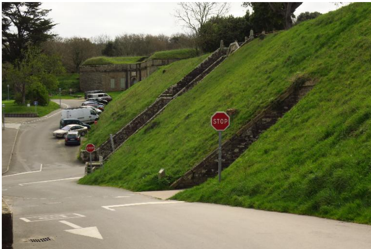
Le Palais, enceinte urbaine, courtine 20-21, côté ville.
