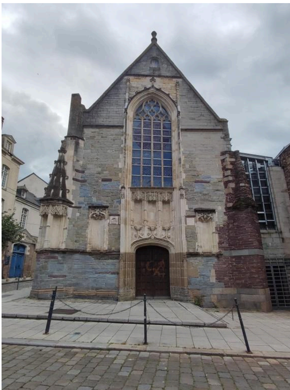
Vue de la façade est
