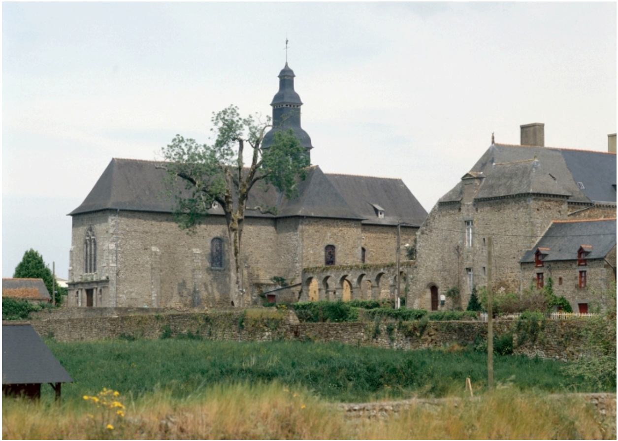
Elévation Sud : vue générale
