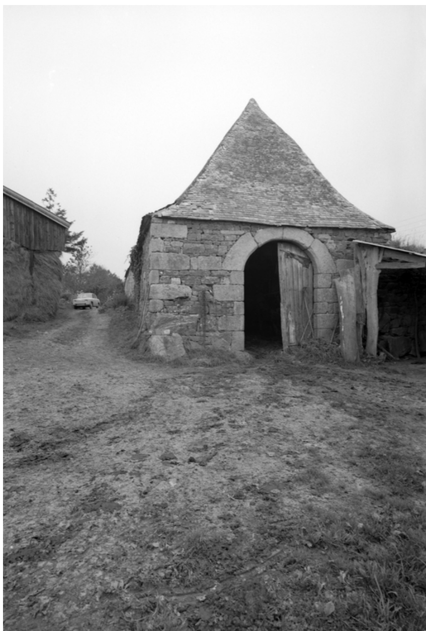
Pignon sud du bâtiment de communs ouest
