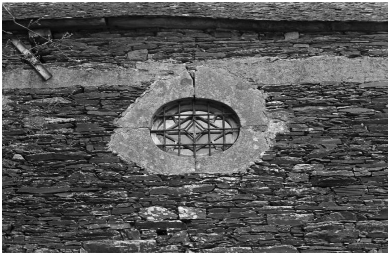
Détail d'une lucarne
