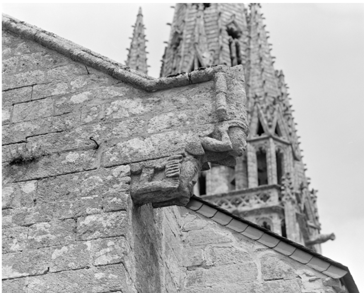
Mur ouest, gargouille sud
