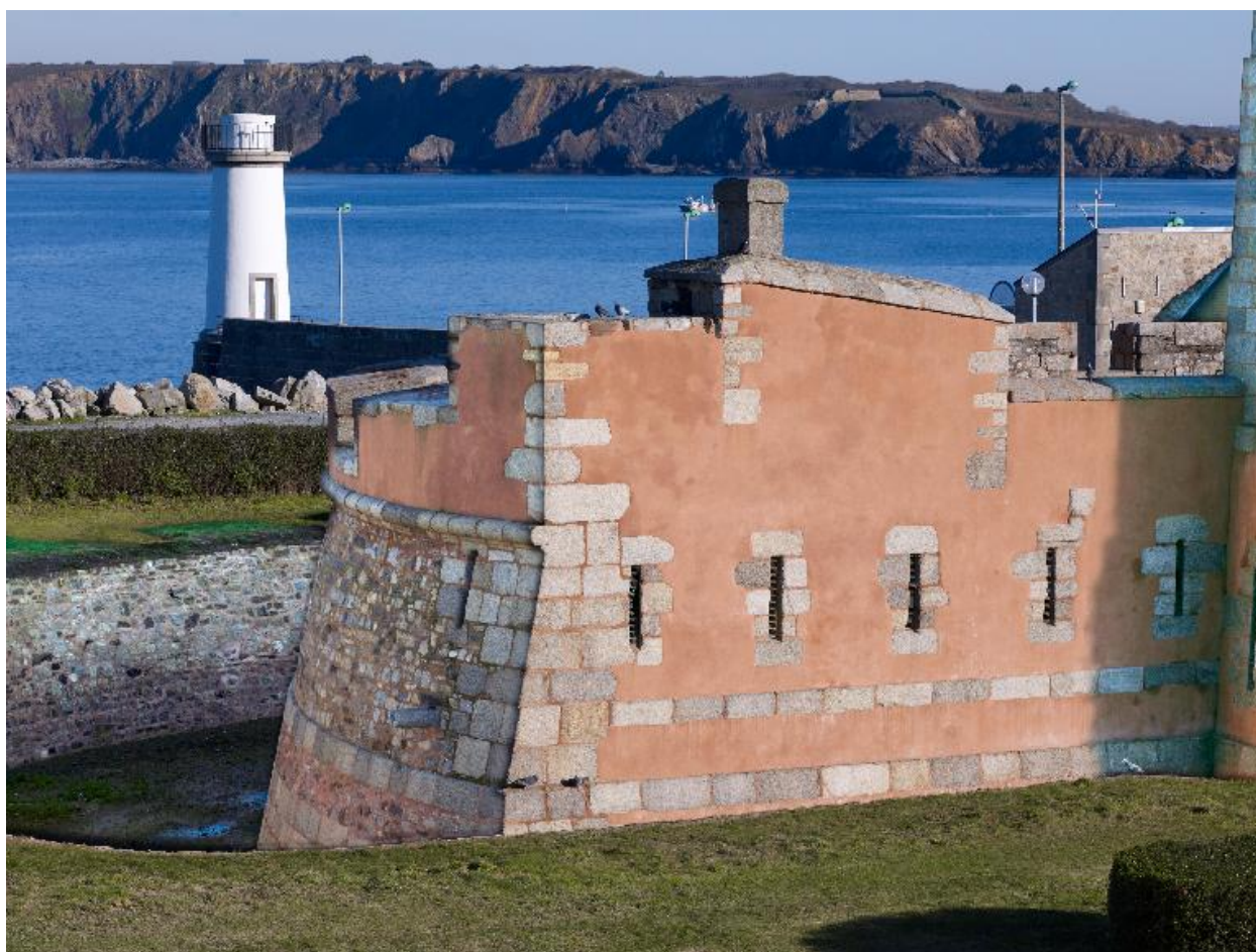
Camaret-sur-Mer : vue de la tour Vauban
