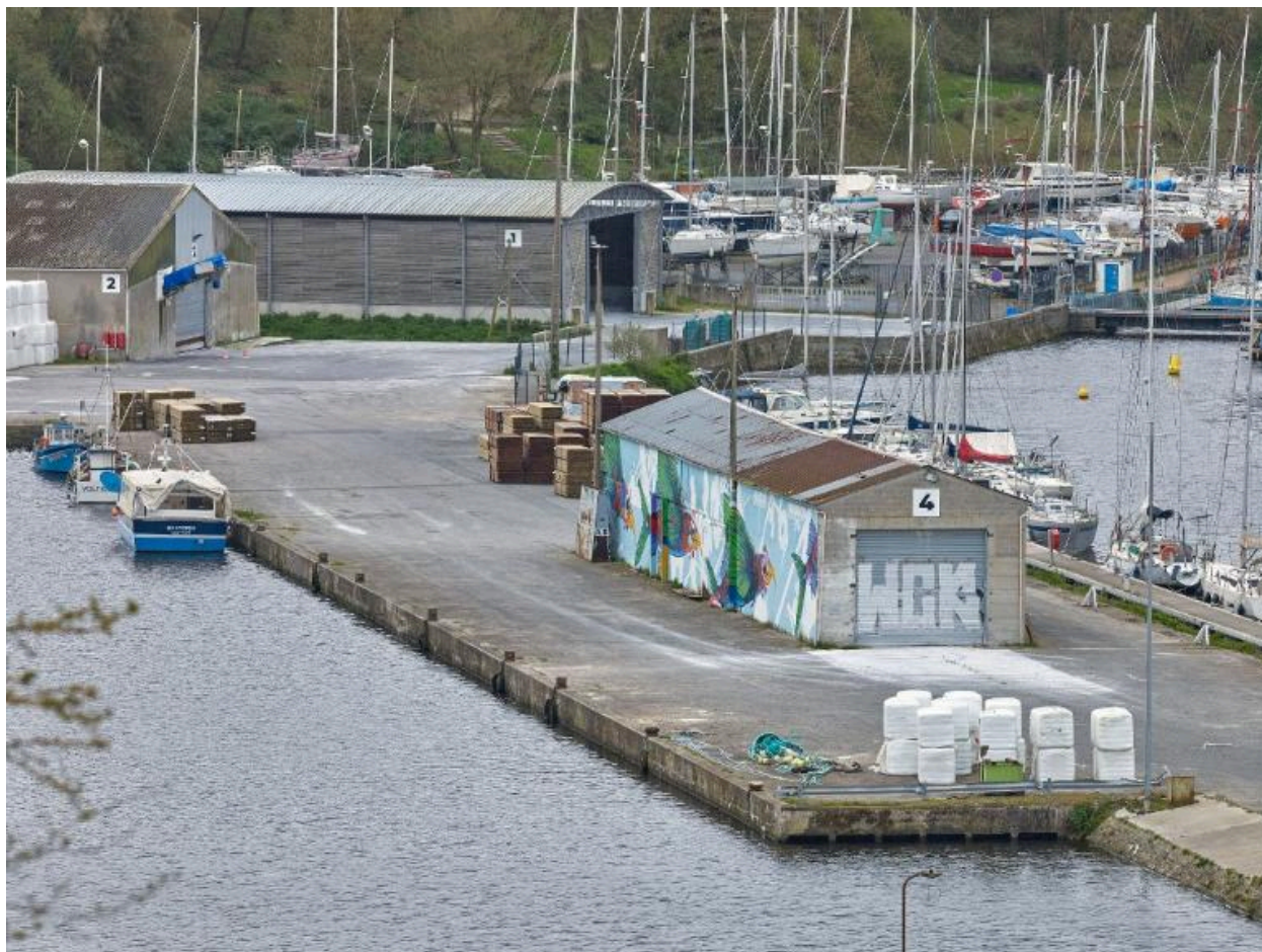
Quai de la presqu'île du bassin Mézaubran
