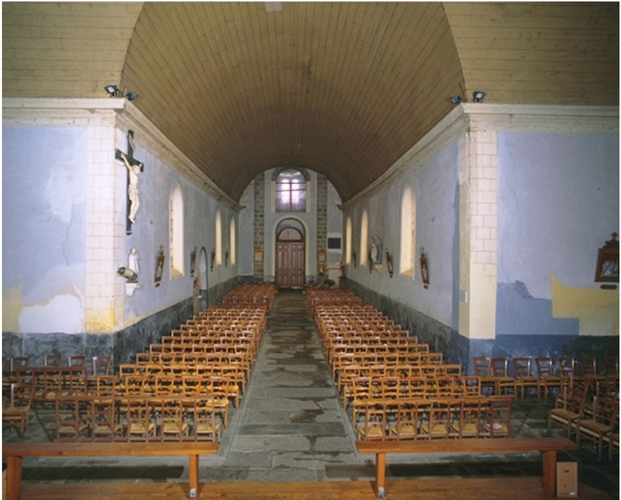
Vue générale vers la nef
