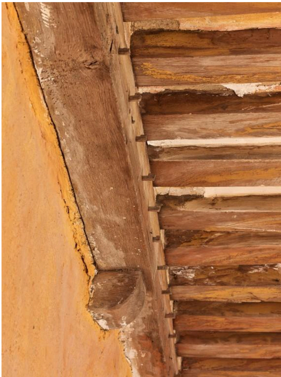
Une succession de crochets chevillés dans la poutre de la pièce à l'étage
