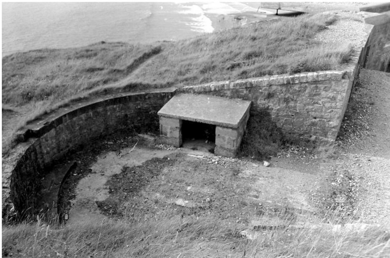
Vue de la batterie de mortier en 1969 : l'une des trois plate-formes de tir à ciel ouvert avec un petit abri en parpaing de béton couvert d'une dalle en béton de faible épaisseur
