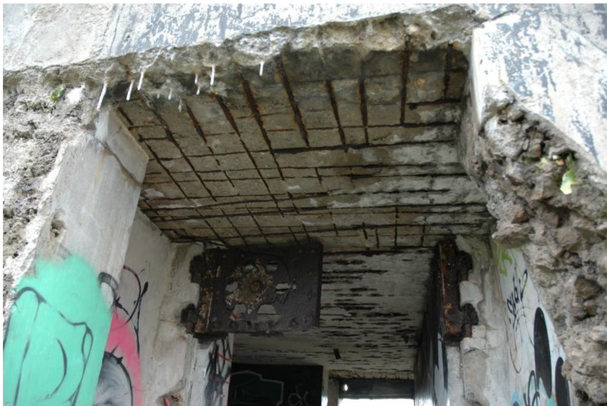
Vue de l'entrée d'un magasin à munitions en béton armé : volets métalliques (état en 2005)
