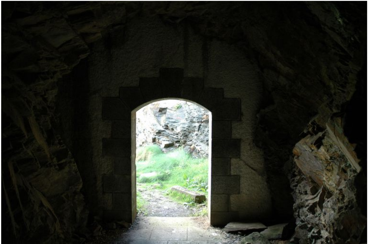
Vue de la batterie de Cornouaille : soute à munitions, ouvrage creusé dans le roc et accessible par un couloir de 2,3 mètres de largeur (3e quart 19e siècle)
