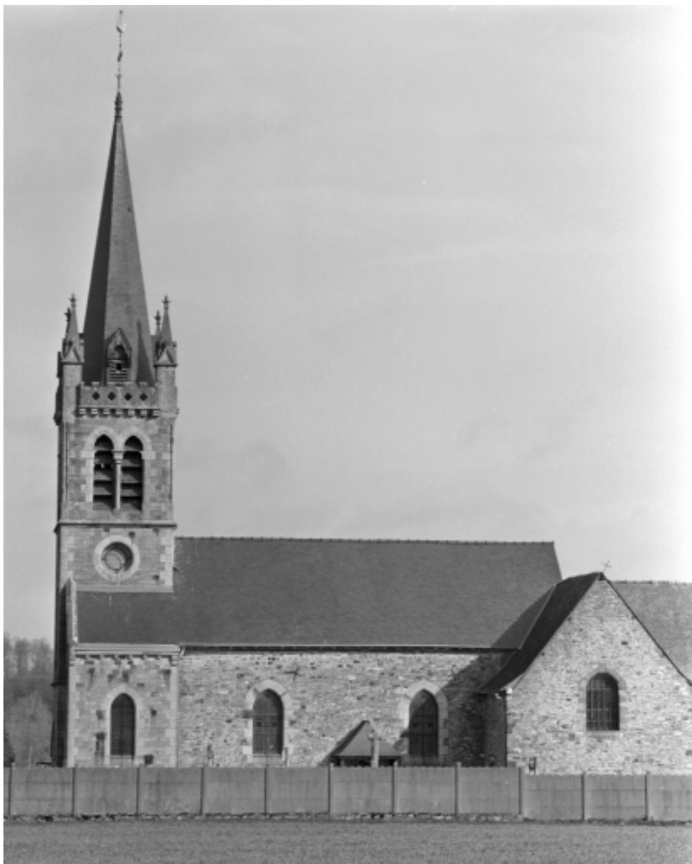
Elévation sud, partie ouest ; vue générale
