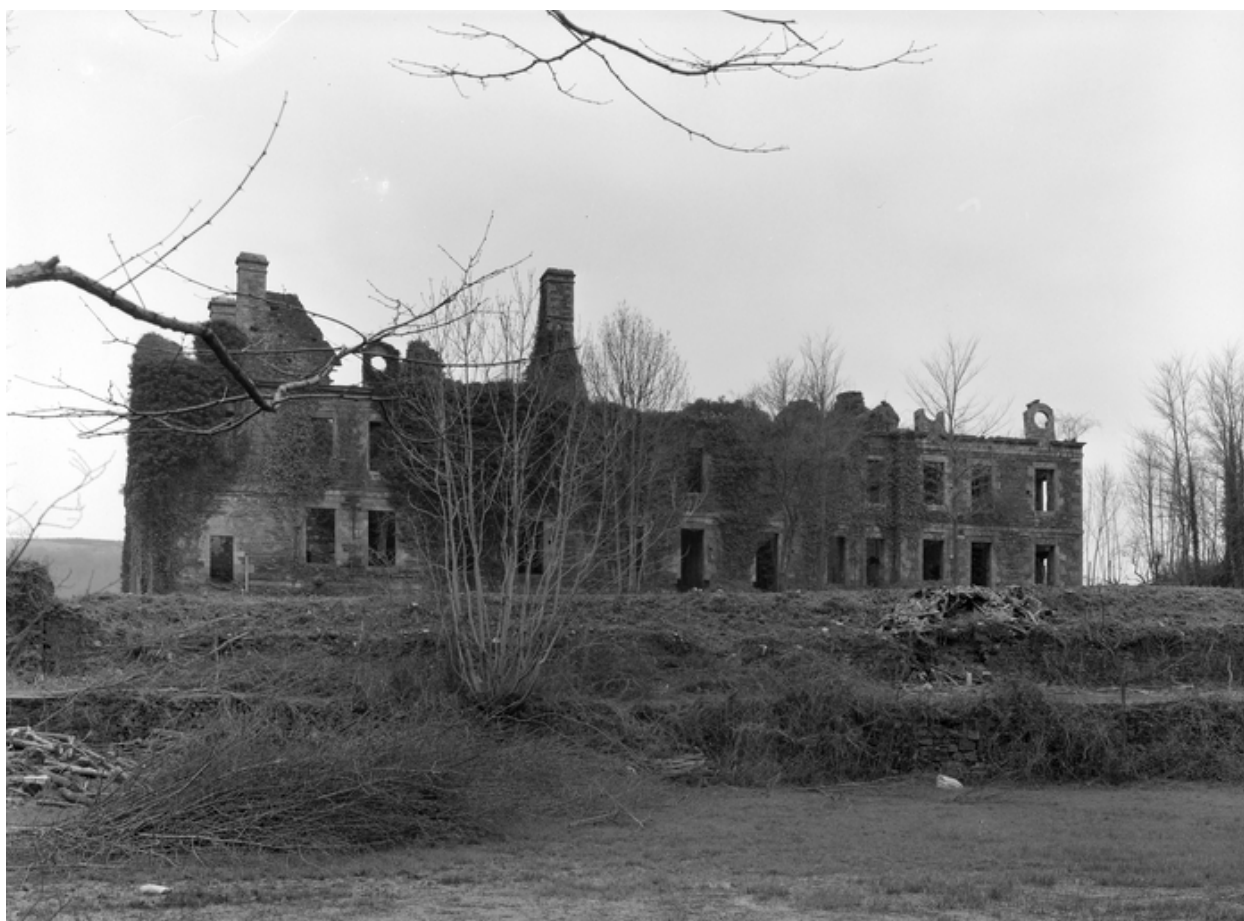
Batiments conventuels : vue générale Sud (état en 1977).
