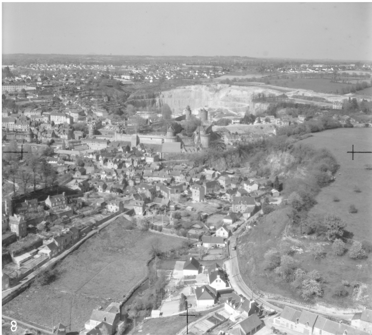
Place Pierre Simon - Vue aérienne sud.
