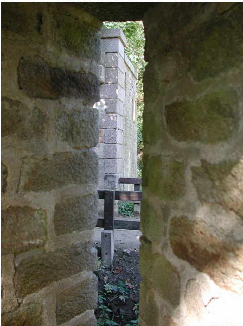
Vue du fort du Dellec : mur d'enceinte percé de créneaux de fusillade. Un des trois créneaux flanquant le pont-levis
