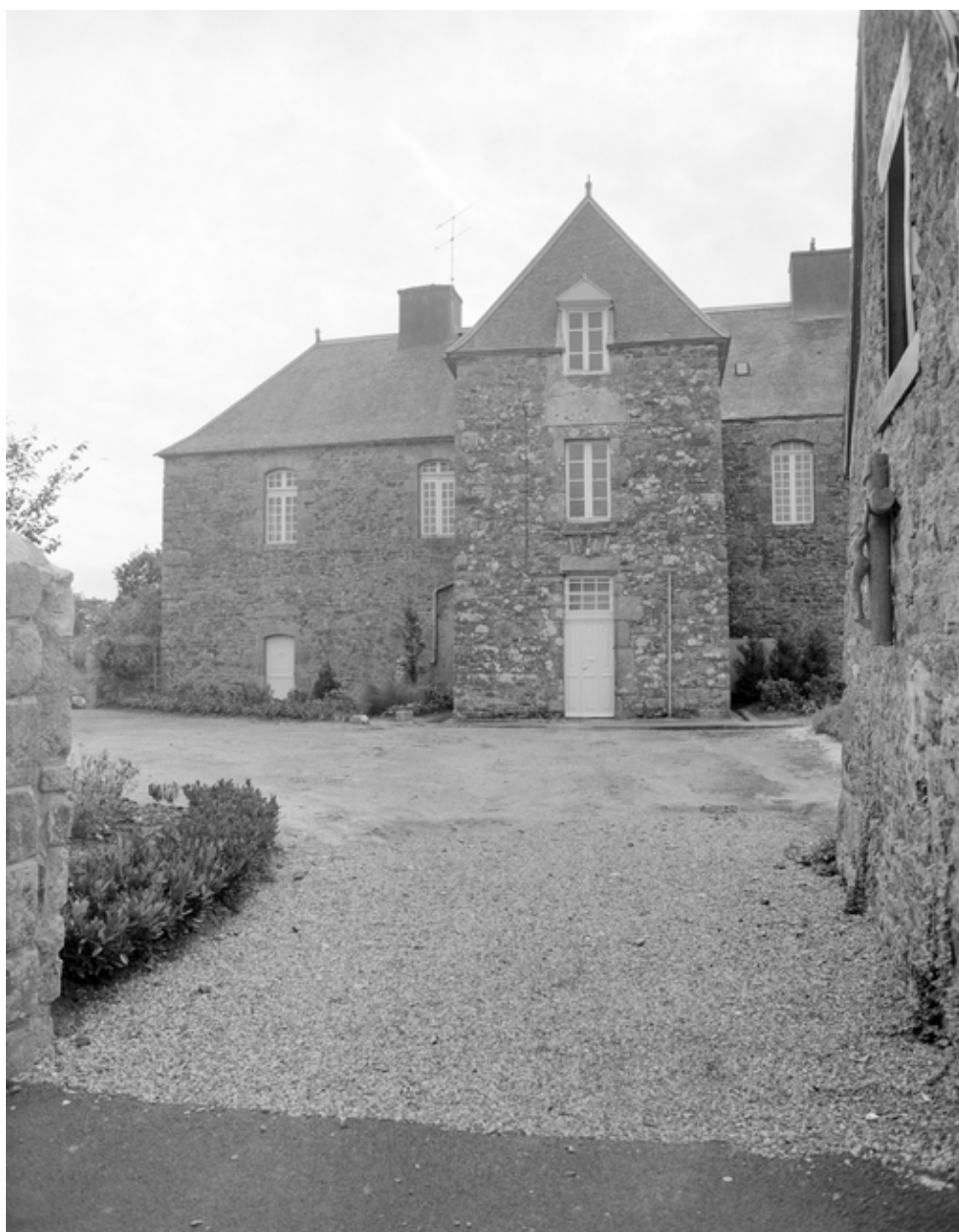
Façade ouest : vue générale
