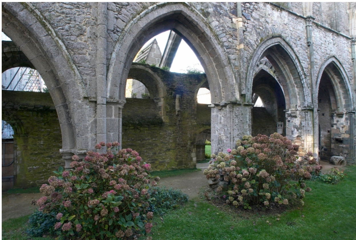
Nef de l'église abbatiale, mur nord
