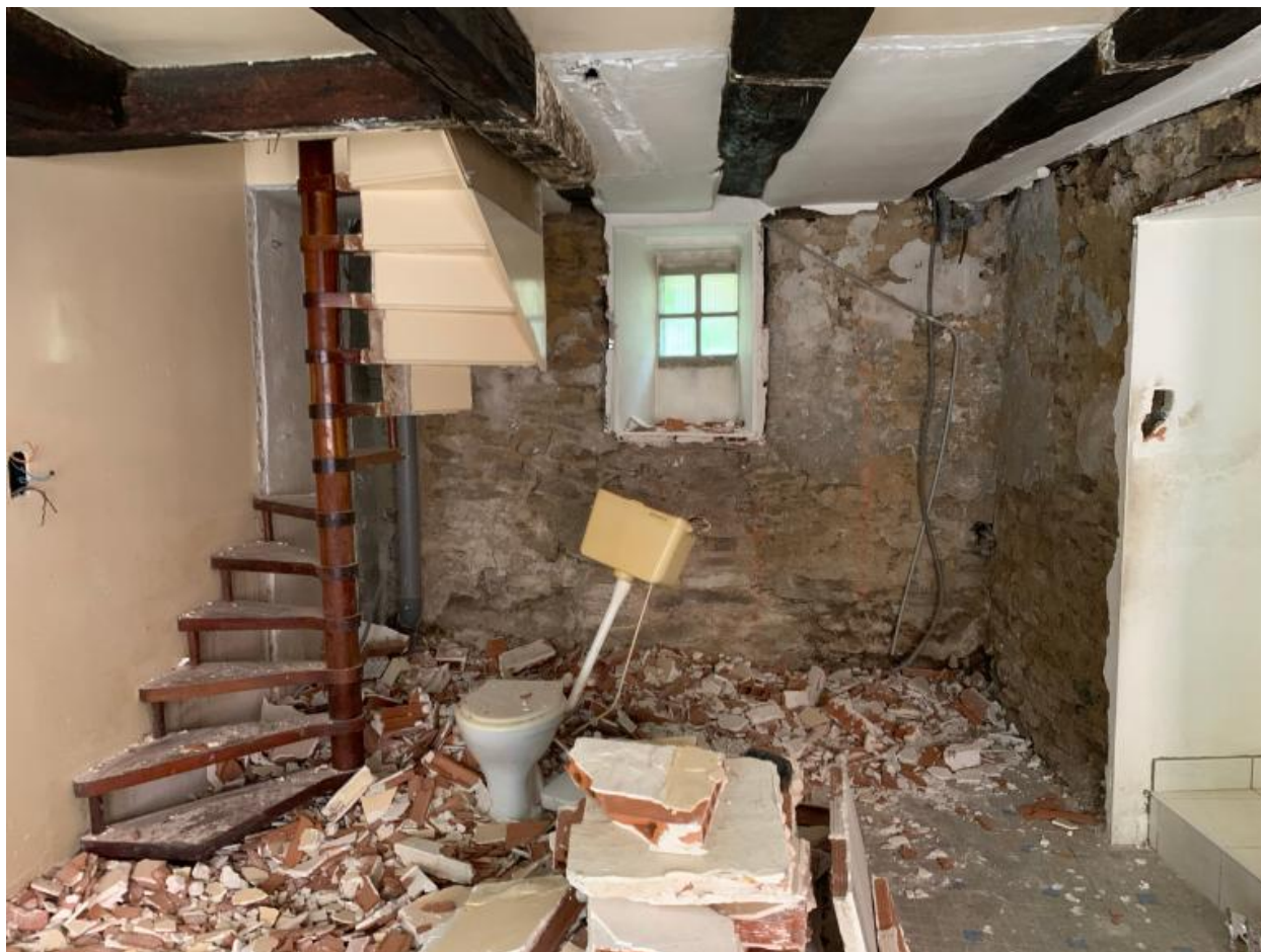
Maison à gauche. Rez-de-chaussée
