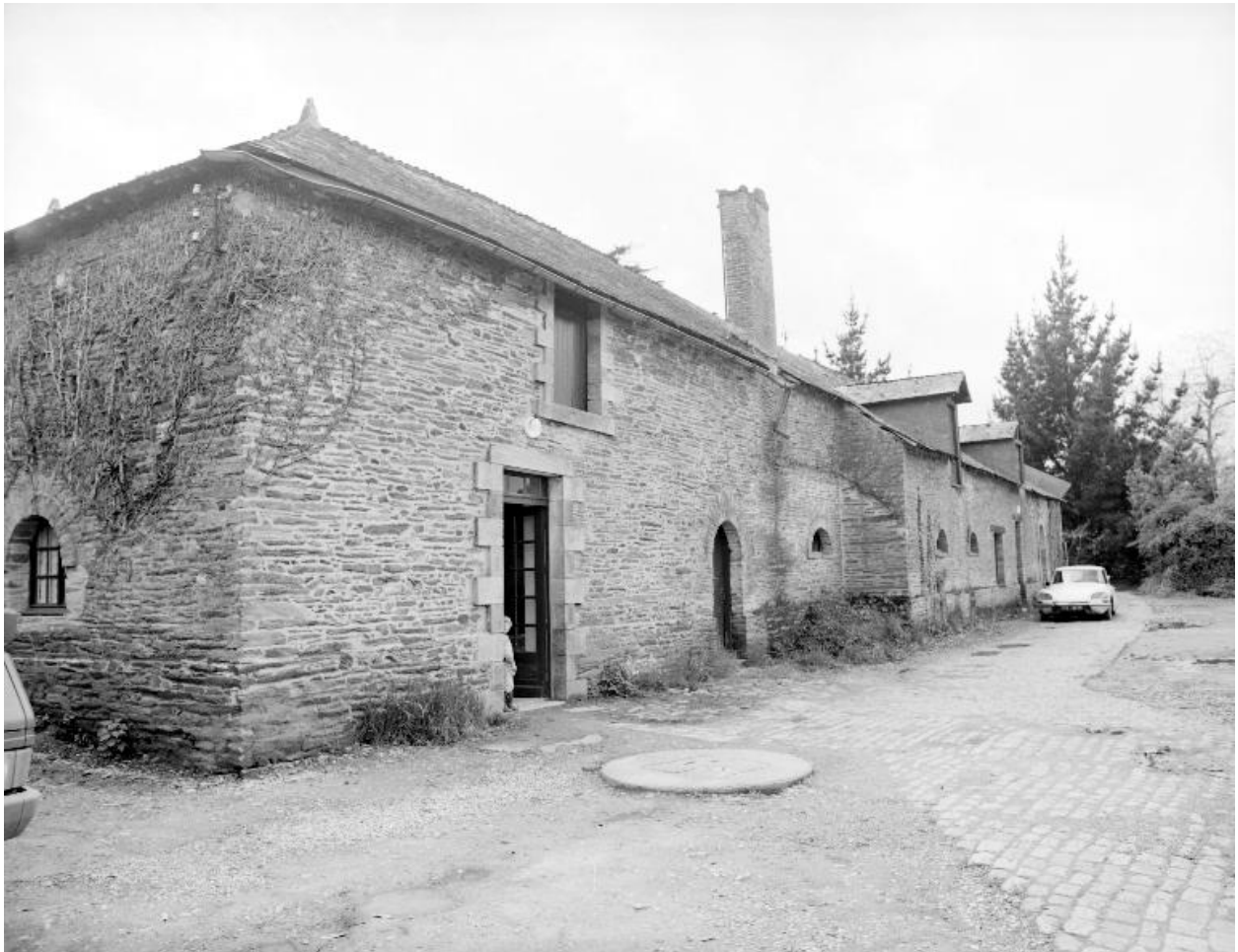
Château : les communs vus de l'est (état en 1983)
