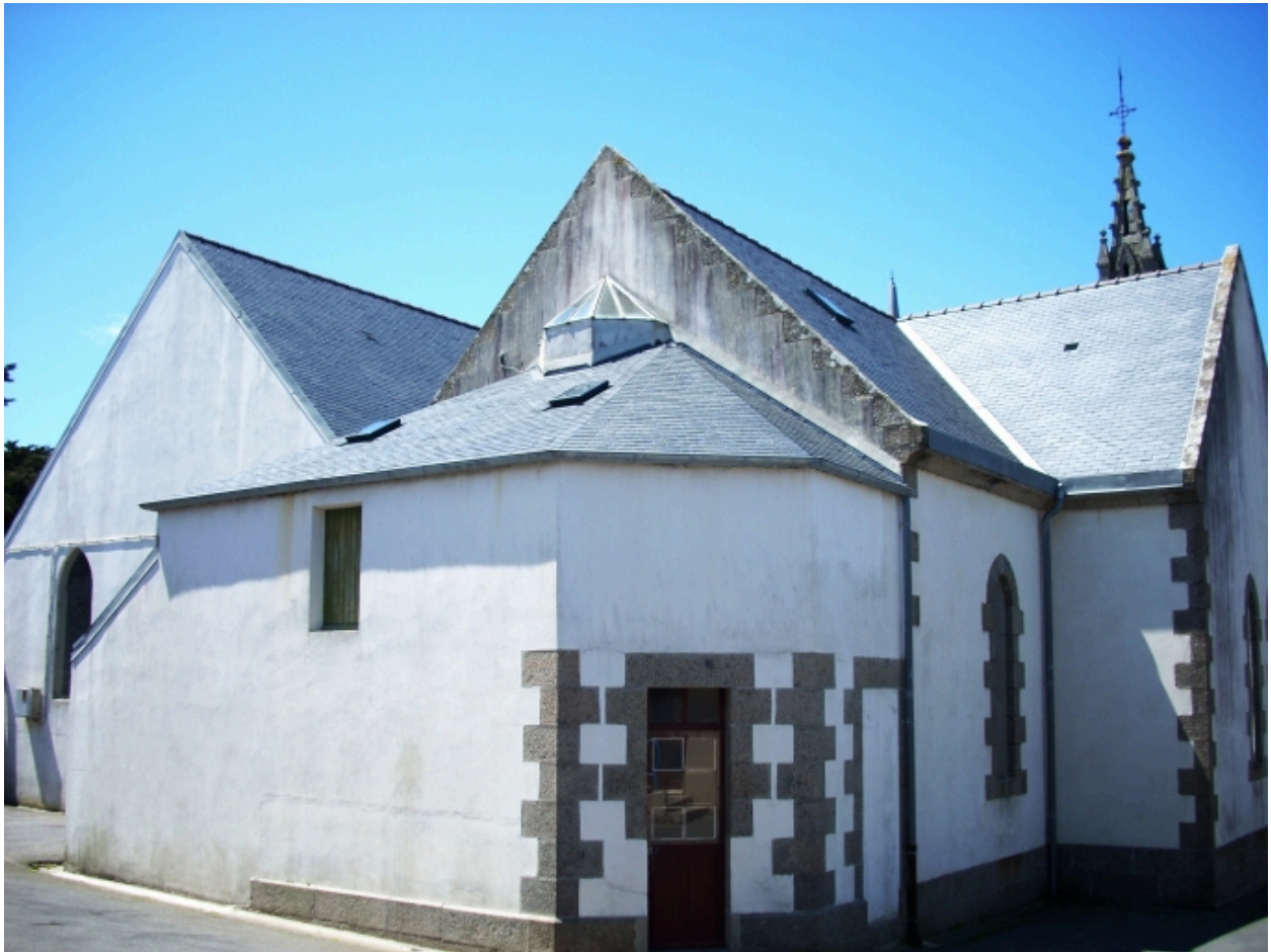
Ploudalmézeau, église de Portsall : vue générale nord-est
