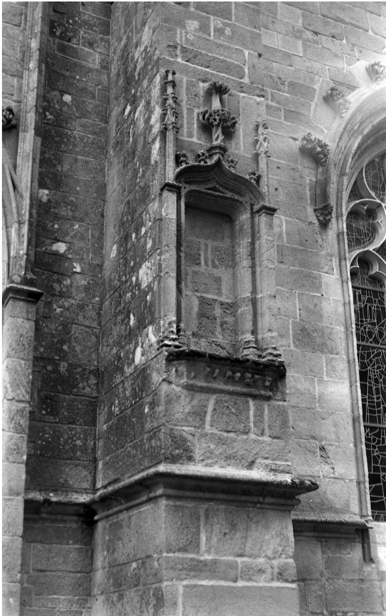
Niche du contrefort est de la porte sud de la basilique Notre-Dame-de-Paradis (16e-19e siècle) (PA00091279)
