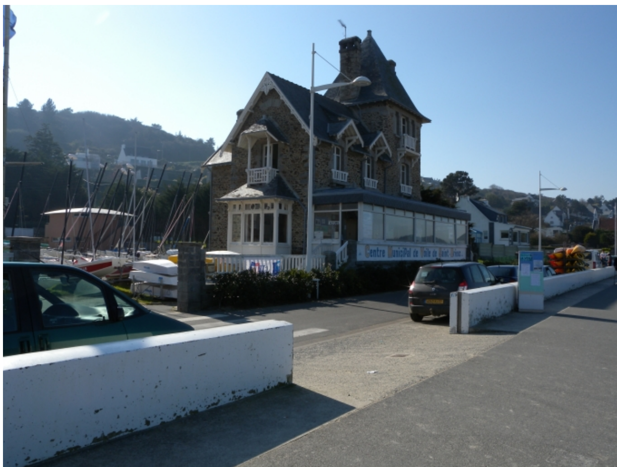
Vue des bâtiments du centre municipal de voile
