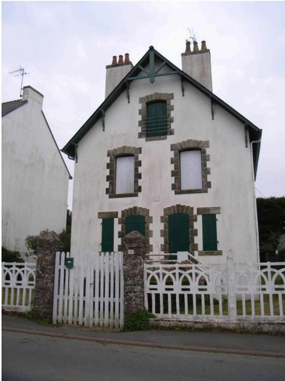
Vue générale de la villa Les Ajoncs
