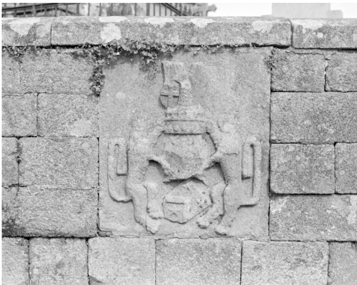
Armoiries (2), mur de l'enclos
