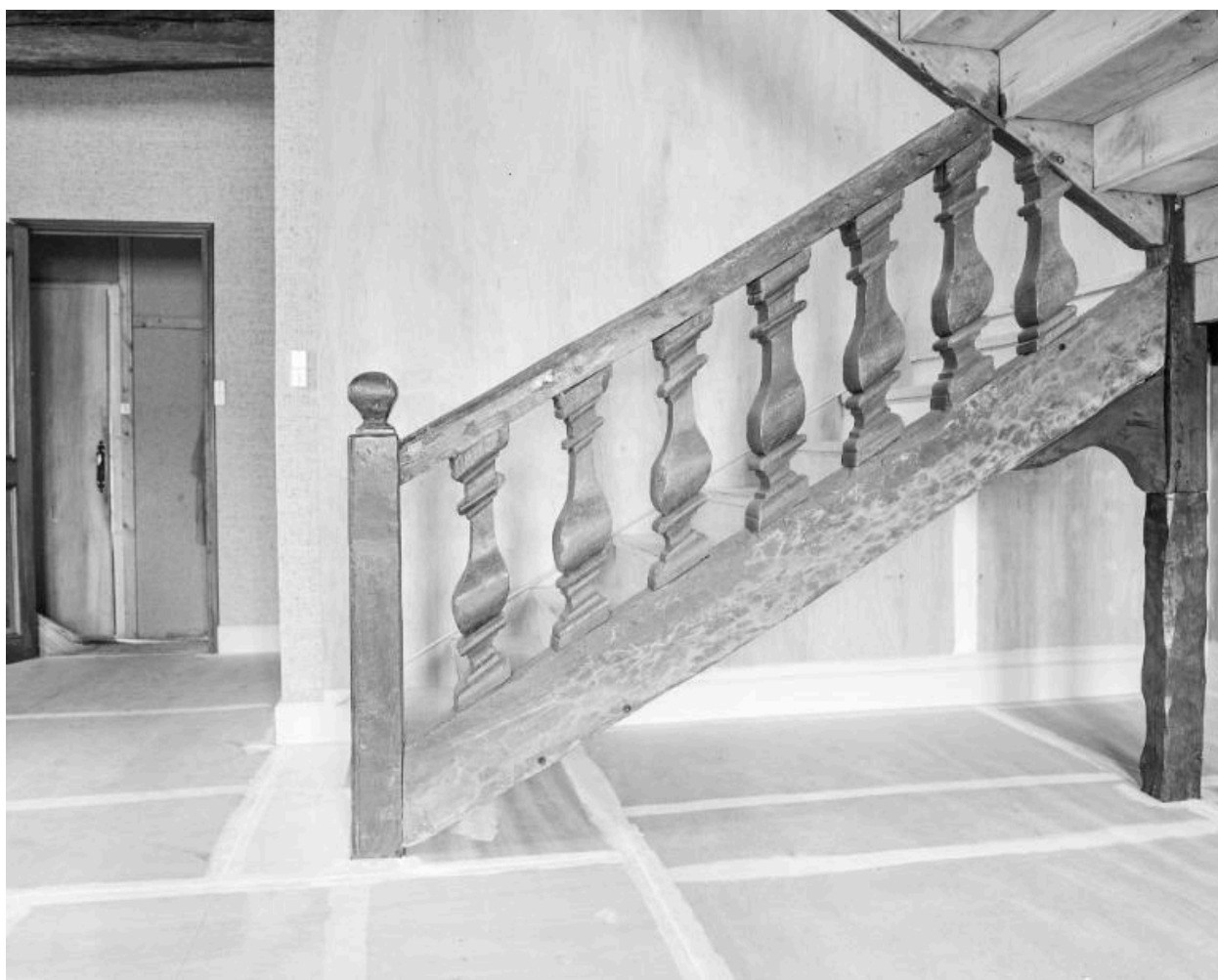
Escalier, garde corps à balustres de plan carré
