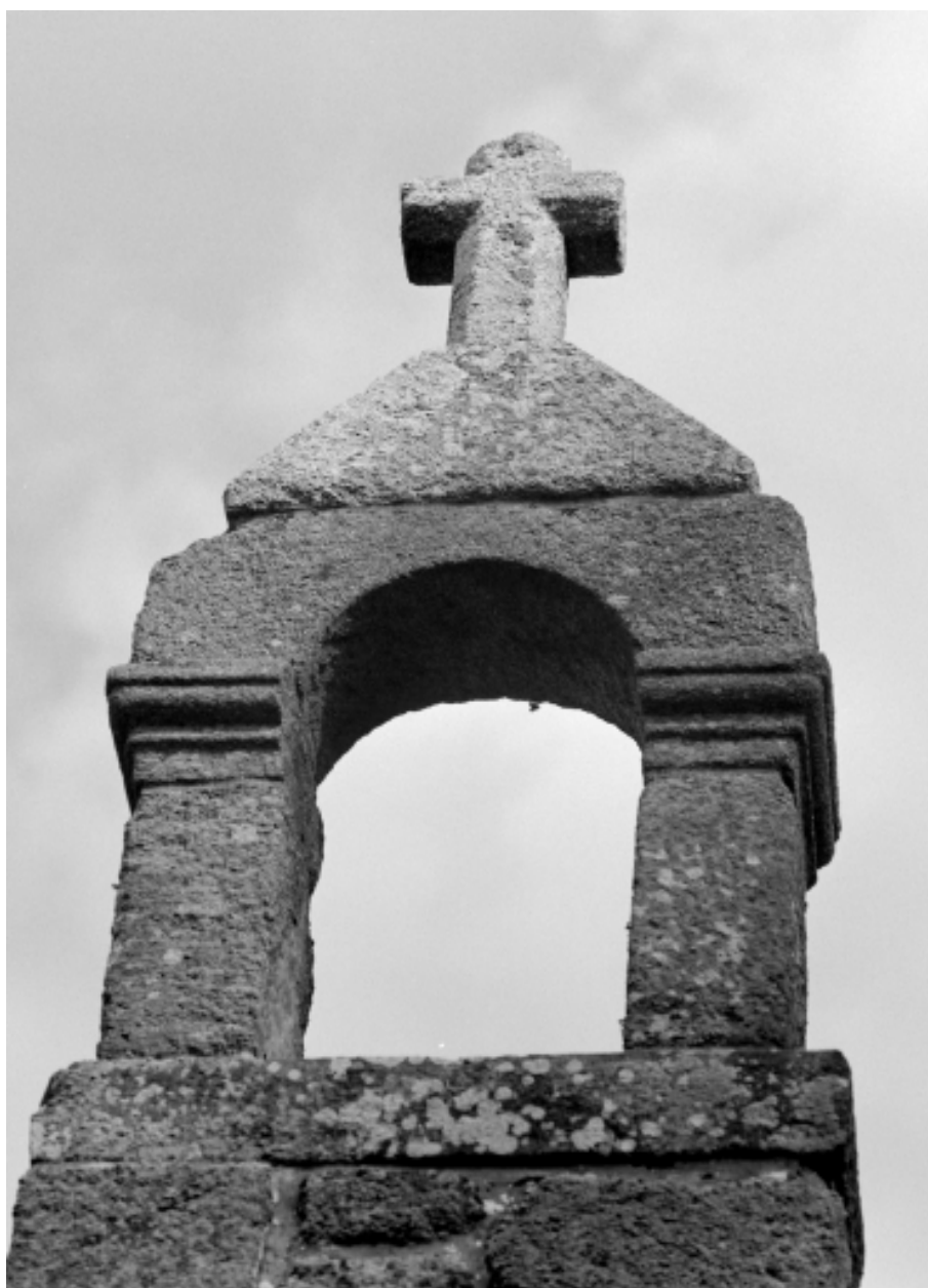
Elévation Ouest : détail du clocher
