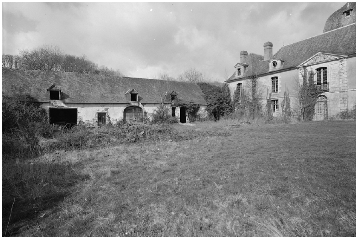
Cour vue sud-ouest.
